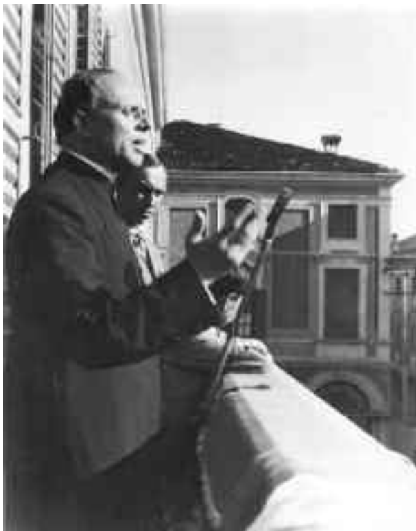
Un discorso di Mazzolari dal palazzo comunale di Viadana
